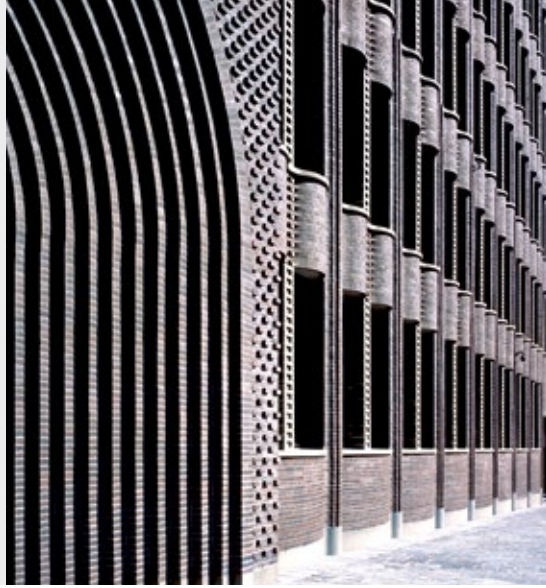
◀ Bremer Landesbank Hauptsitz, DE Architektur: Caruso St John Architects, GB
