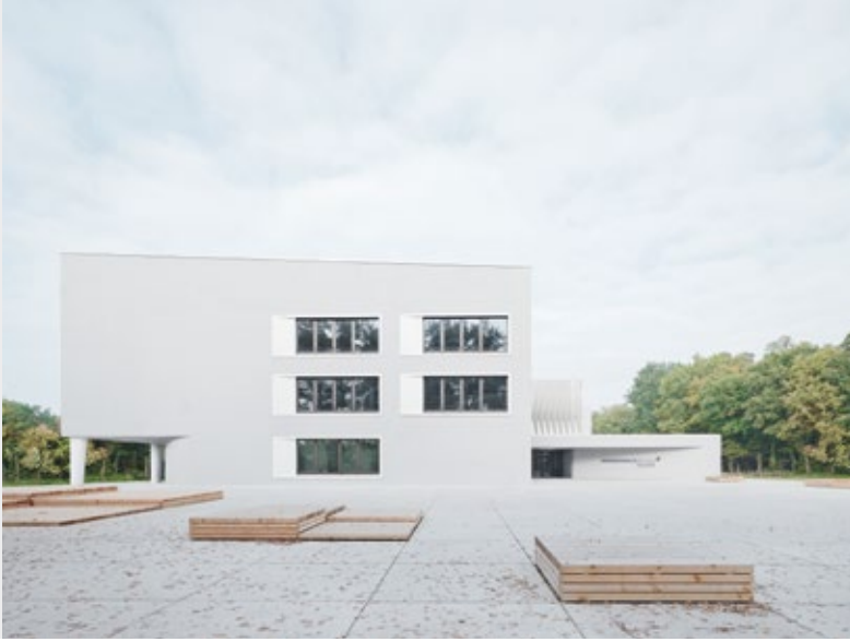
▶ Hessenwaldschule in Weiterstadt, DE Architektur: wulf architekten, DE
