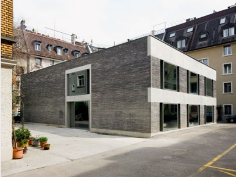
◀ Umbau Atelierhaus Dubsstrasse, CH Architektur: Boltshauser Architekten AG, CH
